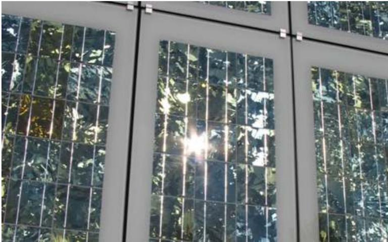
Paneles Solares para Ventanas: Se incorporan en ventanas y tragaluces, aprovechando el espacio vertical disponible para la generación de energía solar.
