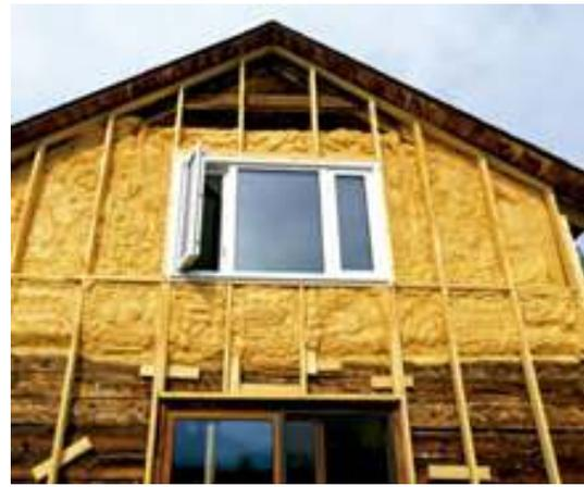
Figura 12. Espuma de poliuretano para aislamiento térmico
